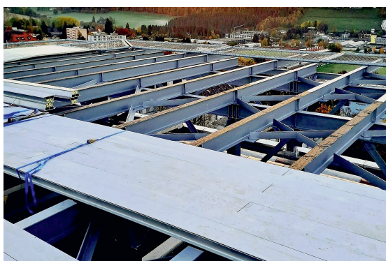
Montage plate-forme hélicoptère à La Chaux de Fonds.
