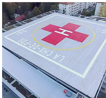
Plancher avec marquage OFAC.
